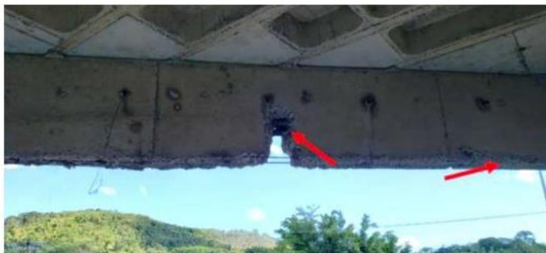
**Figura 07:** Recorte em viga sem reconstrução.
