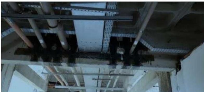
**Figura 06:** Recortes em vigas para passagem de dutos e reforço com fibra de carbono.
