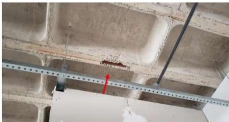
**Figura 10:** Aço exposto na laje devido a nicho de concretagem.
